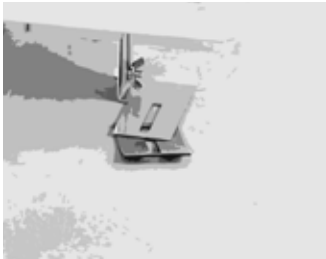
Schallentkoppelungselemente unter die Stellfüsse anbringen.
