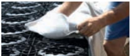
Das Vlies in 200-g/m<sup>2</sup>-Qualität muss der Geotextilrobustheitsklasse GRK 3 entsprechen und kann über Ihren Baustofffachhandel bezogen werden. Für das ACO Stormbrixx Sickerset benötigen Sie 22 m<sup>2</sup>.
