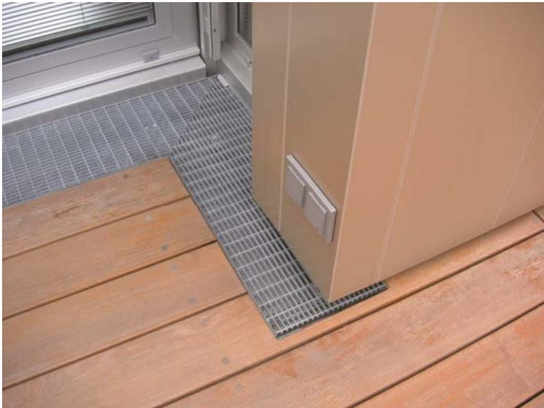
Bildtext: Eine zuverlässige Entwässerung erfolgt nur dann, wenn sich die Entwässerungsrinne über die gesamte Länge der Türanschlüsse erstreckt, wie hier beim Dachgeschoßausbau in der Nibelungengasse.
