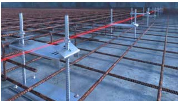
Höhenanpassung der Einbauhilfe auf gewünschtes Niveau mittels Laser oder Richtschnur. Flanshhöhe muss der Höhe der Beschichtungsebene entsprechen. (Unterkante Beschichtungsflansch = Oberkante Rohbetondecke) Die Höhe der Rinnenoberkante (Zarge) soll so ausgerichtet sein, dass die Zarge keinen Hochpunkt darstellt und somit eine funktionierende Entwässerung gewährleistet wird. Deckline P OS auf die Traverse der ACO Einbauhilfe legen.
