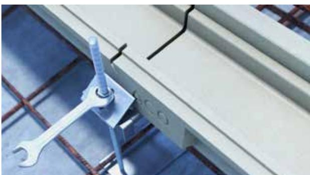
Rinne durch Festziehen der Verkrallungsmutter (M 10) im Stoßbereich gegen Verrutschen und Auftrieb sichern. Dabei auf die Ausrichtung des Rinnenstranges und Übergänge achten. Der Rinnenstrang sollte bis zum Aushärten des Betons nicht belastet oder bewegt werden.
