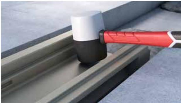
Die Zarge darf keinen Hochpunkt darstellen, um eine funktionierende Entwässerung zu gewährleisten. Der Beschichtungsflansch sowie die Oberfläche der Rohbetondecke müssen auf derselben Höhe angebracht werden.
