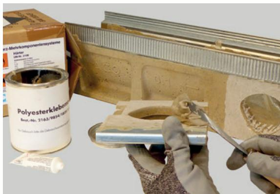
Für das Verkleben sollte die Polyesterklebmasse mit dem richtigen Mischungsverhältnis des Härters vermischt, auf die Klebeflächen aufgebracht und schlussendlich beide Teile miteinander verklebt werden (siehe beiliegende Anleitung).
