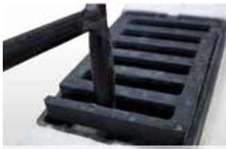
2. Aufhebeln des Rostes
