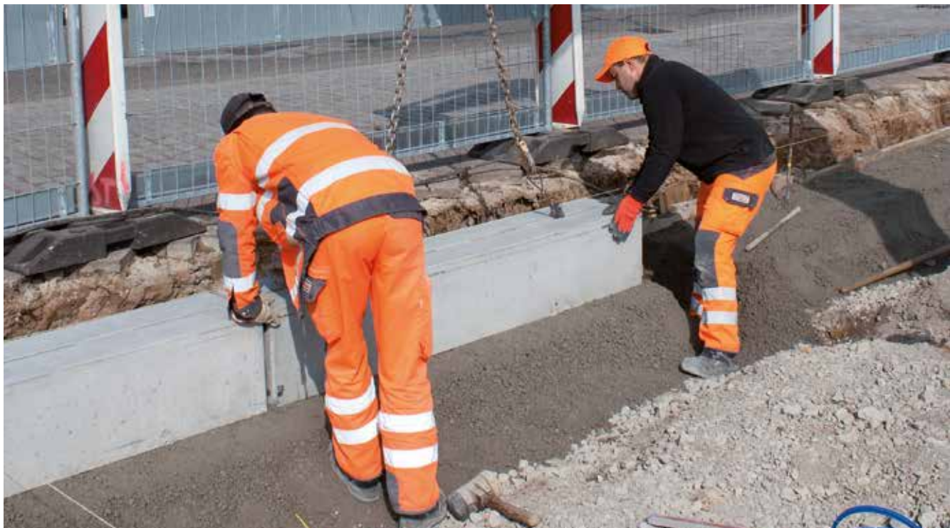
Einbausituation City Drain 150
