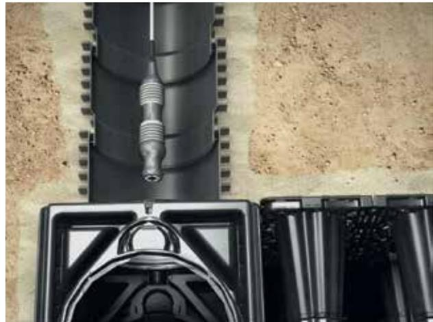
Einführen der Kamera über den vorgelagerten Inspektions- und Spülschacht
