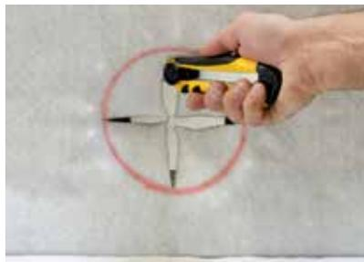
Für das Anzeichnen der Öffnungen auf dem Geotextil wird ein Permanentmarker und zum Schneiden ein Cuttermesser benötigt.
