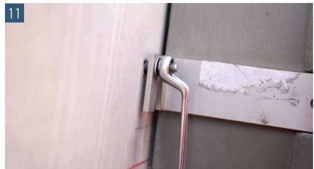
11 Ziehen Sie die Muttern über Kreuz an, so dass das Dichtungsband Dichtfix auf ca. 5 mm zusammengedrückt wird
