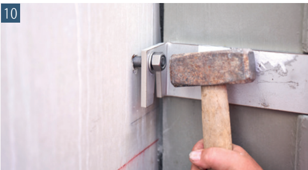
10 Schlagen Sie nun die beiden oberen Schlaganker durch die Rundlöcher des Befestigungswinkels ein
