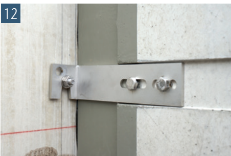
12 Ziehen Sie nach 10 Minuten die Muttern erneut über Kreuz an, so dass das Dichtungsband Dichtfix bis auf 3 mm zusammengedrückt wird
