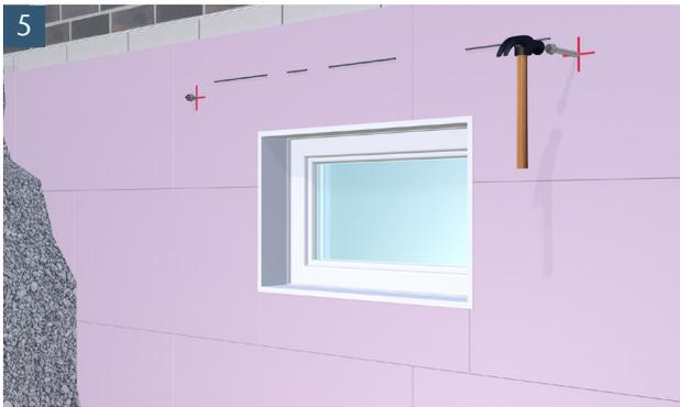
5 Bei Montage direkt an Kellerwand Kunststoffdübel setzen, bei Montage auf Perimeterdämmung Schwerlastanker einschlagen. Schlagen Sie den Schwerlastanker soweit ein, dass max. 30 mm zur Lichtschachtmontage überstehen.
