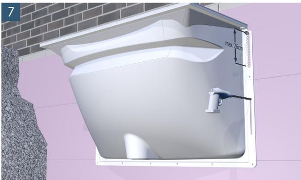
7 Bohrungen im Langloch links und rechts setzen
