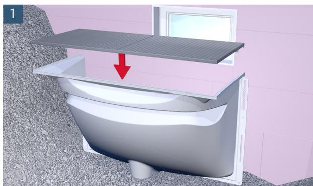
Rost in Lichtschacht einlegen. Die Abhebesicherungsketten an den beiden gelochten Tragstäben eingehängen und mit den mitgelieferten Schrauben (mit 4 mm Bohrer vorbohren) am Lichtschacht möglichst weit oben befestigen.
