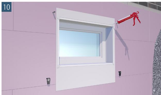
10 Dichten Sie das Dämmungsanschlussprofil oberseitig ab
