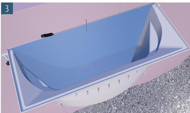
3 Markieren Sie die Oberkante der Rückwand und setzen Sie zudem eine senkrechte Markierung zur späteren Orientierung
