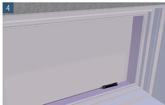
4 Übertragen Sie die Fensterausparung auf die Rückseite der Rückwand. Achten Sie darauf, dass die Dämmung unmittelbar an die Schalungsdichtung bzw. der Einstecknut des Leibungskellerfensters angearbeitet ist, so dass der Fensterauschnitt nicht zu groß ausfällt
