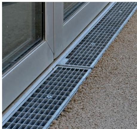
Detailansicht ACO E100K Fassadenentwässerungsrinne im Türbereich
