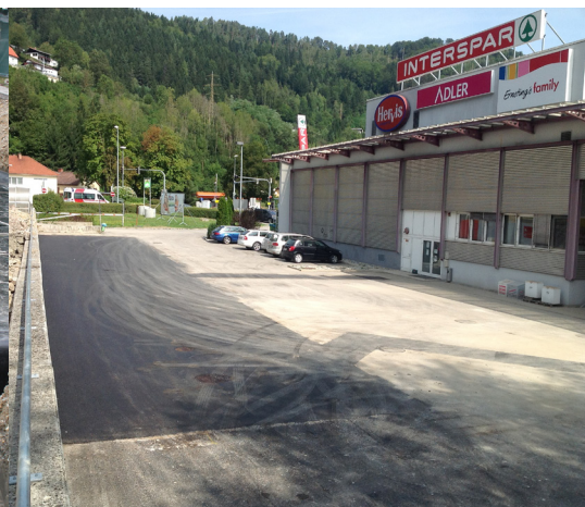
Fertiger Einbau der Versickerungsrigole der Dachflächen NORD/SUD
