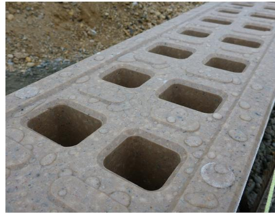
Polymerbeton ist wasserundurchlässig
