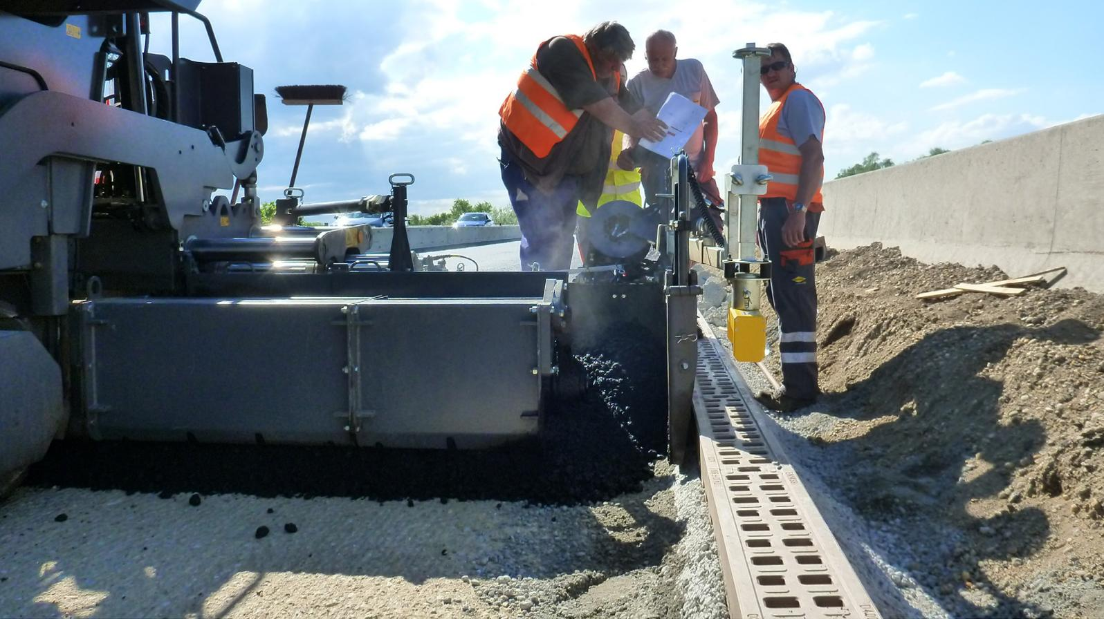
Asphaltieren mittels Asphaltfertiger direkt an der Rinne
