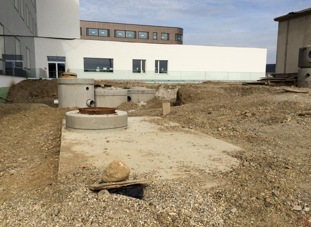
Von hier aus können die Löschwässer einer geordneten Entsorgung zugeführt werden, sodass keine Gefahr für eine Grundwasserkontamination besteht. Die Betätigung des Umschalt-schachtes kann im Störfall von 2 Stellen aus erfolgen: vom 5. OG des Treppenhauses und von der ständig besetzten Portierloge.
