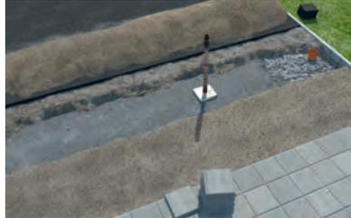
2. Den erdfeuchten Magerbeton (C 15/ B 15) in den Graben füllen und verdichten.
