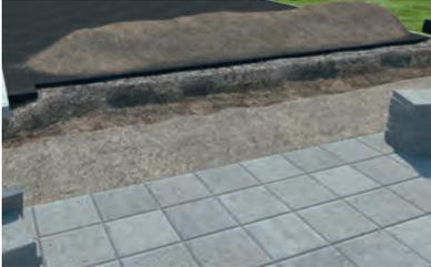
1. Graben für das Betonbett ausheben. Das Betonbett soll später ein Mindestmaß von 5 cm Höhe und 20 cm Breite haben. Wir empfehlen die vordere und die hintere Reihe der Pflastersteine auch mit in ein Betonbett zu setzen. (siehe Seite 25)
