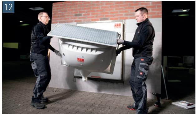
Hängen Sie den Lichtschacht an die zuvor gesetzten Schrauben an und überprüfen Sie die korrekte Lage des Lichtschachtes. Im Anschluss kann die Schutzfolie vom Abdichtungsband entfernt und der Lichtschacht leicht angedrückt werden
