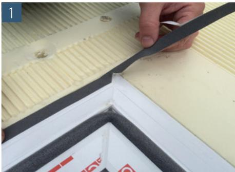
1 Vor dem Ankleben des Therm® Blocks das Komtriband am äußeren Rand des Abdichtungsflansches der Zarge aufkleben. Ecken mit Hilfe eines V-förmigen Ausschnitts ausbilden
