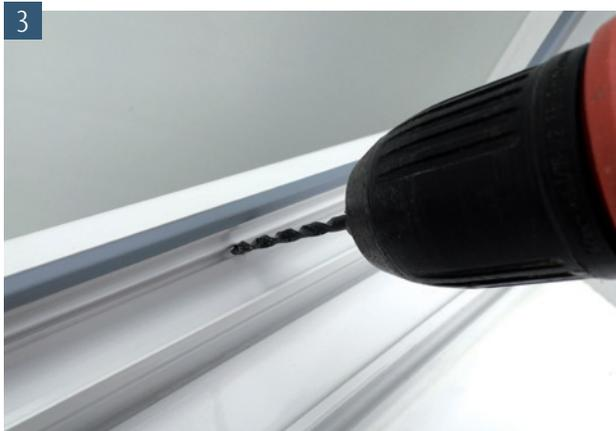
Durchbohren Sie im 45 Grad-Winkel die innere Wandung. Bitte nicht tiefer als 1 cm bohren
