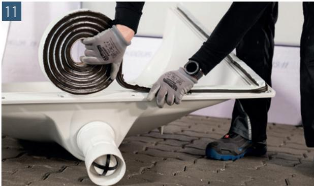
Kleben Sie das Abdichtungsband Dichtfix auf den trockenen und staubfreien Lichtschachtflansch auf. Das auf Zimmertemperatur gebrachte Abdichtungsband innenseitig der Befestigungspunkte platzieren. Die Befestigungspunkte und oberseitigen Langlöcher zu ca. 1/3 überdecken. Schutzfolie in den Ecken durchtrennen aber noch nicht entfernen
