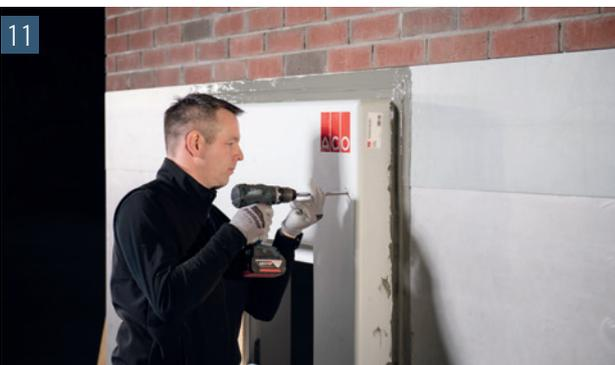
Die beiden oberen Befestigungspunkte mit Tellerkopfschrauben ohne Beilegescheibe bestücken. Drehen Sie die Schrauben bis auf ca. 3 cm ein. Vorbohren ist nicht zwingend erforderlich
