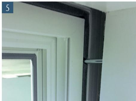
5 Führen Sie die Bolzen in die Öffnungen am Schalungselement ein. Fixieren Sie den Therm® Block mit Kanthölzern und Schraubzwingen für ca. 1 Stunde
