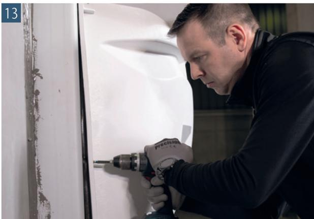
Verschrauben Sie den Lichtschacht umlaufend mit dem Therm® Block. Hierzu sind alle vorhandenen Befestigungspunkte am Lichtschacht zu nutzen. In den oberseitigen Langlöchern sind in jeweils 2 Schrauben mit großer Beilegescheibe zu platzieren. Drücken Sie das Abdichtungsband Dichtfix auf ca. 5 mm zusammen. Nach ca. 30 Minuten die Schrauben nochmals nachdrehen und das Abdichtungsband auf ca. 3 mm zusammendrücken
