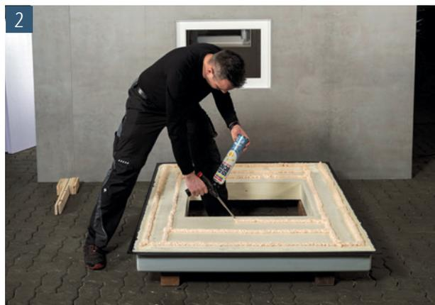
Ausreichend Dämmplattenkleber wie dargestellt aufsprühen. Therm® Block mit Fensterausparung: ca. ½ Dose Therm® Block mit integrierter Zarge: ca. ¾ - 1 Dose
