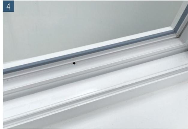
Entfernen Sie abschließend die Bohrspäne
