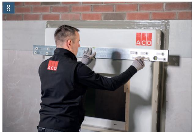
Markieren Sie die oberen Befestigungspunkte des Lichtschachtes. Hierzu kann die ACO Bohrschablone genutzt werden.
