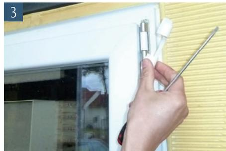
3. Fenstergriffe in Drehstellung lassen und Beschlagsabdeckung entfernen
