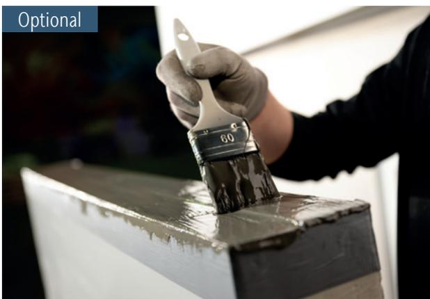
Sofern der Therm® Block oberseitig gekürzt werden sollte, kann dies mit einer Kreissäge mit einem feinzahnigen Sägeblatt erfolgen. Die Schnittfläche bitte komplett mit Aqua Blocker versiegeln
