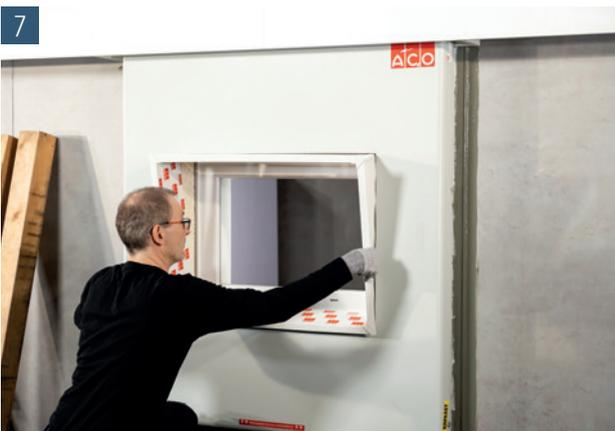
Fügen Sie das Dämmungsanschlussprofil laut beiliegender Anleitung zusammen und klicken dieses in die Dichtungsnut des Fensters ein
