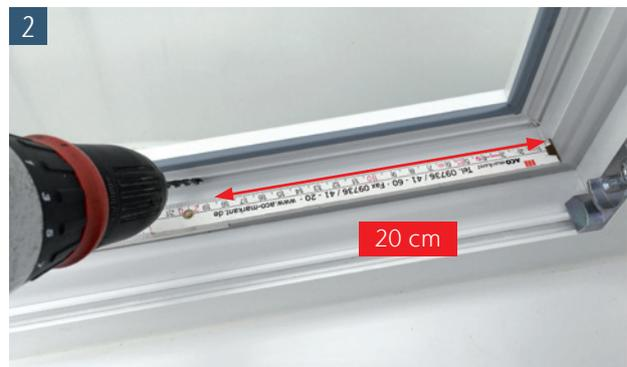
Von innen müssen ebenfalls 2 Bohrungen mit einem 4 mm Bohrer gesetzt werden. Die inneren und äußeren Bohrungen sollten immer versetzt zueinanderstehen, um Windgeräusche zu verhindern
