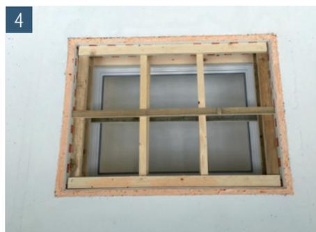
4 Aussteifungsrahmen einfügen und Leibungselement rundum einschäumen
