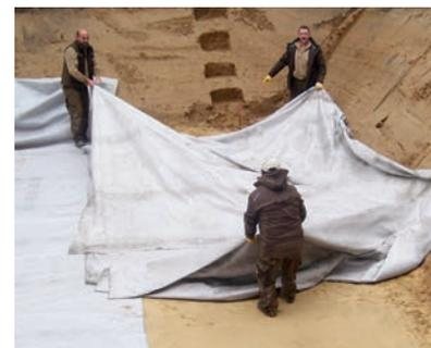
Nach Erstellung des ebenen, stein- und gefällefreien Planums wird die Baugrube mit einem Filtervlies ausgelegt
