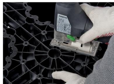
Für das Ausschneiden der Öffnungen für die Rohrdurchführungen an den Seitenwänden und auf der Oberseite der Grundelemente wird eine Stichsäge mit extralangem Sägeblatt benötigt
