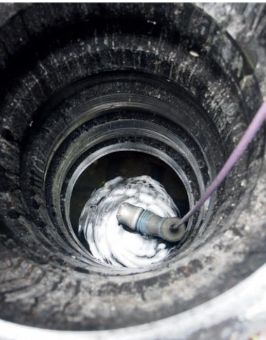
Schiebekamera, Reinigungsgerät mit Spülkopf
