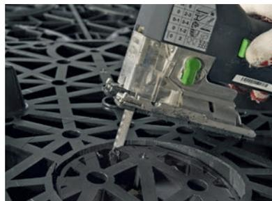
Für das Aussägen der Rohranschlussöffnung an der Seitenwand wird eine Stichsäge mit extralangem Sägeblatt benötigt
