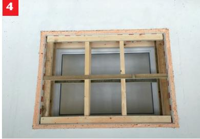
4. Setzen Sie bitte die im Lieferumfang enthaltenen Aussteifungsrahmen in das Leibungselement ein. Spritzen Sie den Spalt zwischen Leibungselement und Leibung mit Dämmplattenkleber oder Montageschaum aus. Schneiden Sie den ausgehärteten Schaum bündig zur Wand ab.
