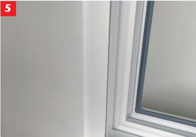
5. Bitte dichten Sie den Übergang von Fensterzarge zum Leibungselement mit Acryrub ab.
