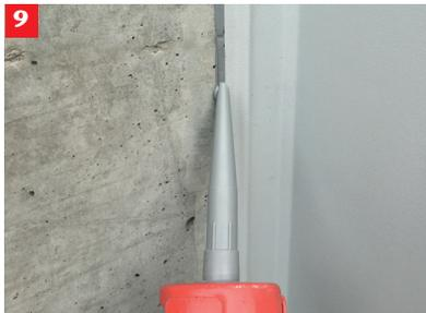
9. Nach dem Ankleben und Fixieren des ACO Therm® Blocks mittels Schraubzwingen und Kanthölzern kann mit der Abdichtung des ACO Therm® Blocks begonnen werden.
