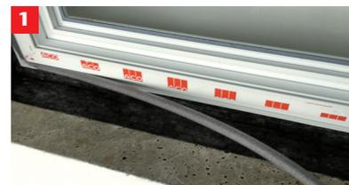
1. Bitte entfernen Sie die graue Dichtung aus der Fensterzarge.
