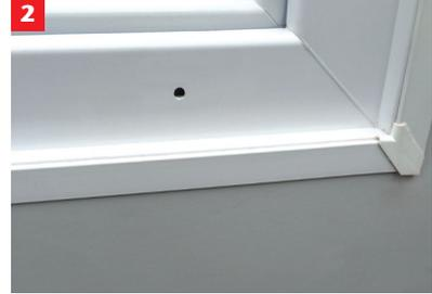
2. Von außen werden jeweils links und rechts zwei 8 mm Bohrungen gesetzt. Die Bohrungen sollten sich in 3,5 cm Höhe und von der Außenkante um 15 cm versetzt befinden. Bitte achten Sie darauf, dass nur die äußere Wandung durchbohrt wird.
