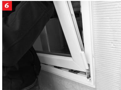
6. Flügel anschließend vom unteren Ecklager heben.
