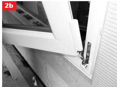
2. Fensterflügel mittels der Griffolive in Drehstellung bringen und auf das Ecklager aufsetzen.
