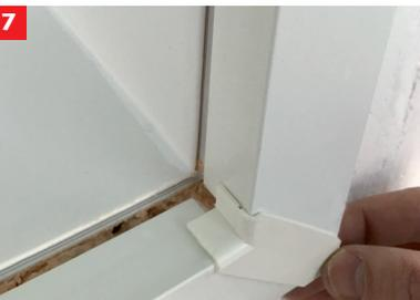
7. Drücken Sie zum Abschluss der Montage den Abdeckrahmen in die Nut des Leibungselementes.
