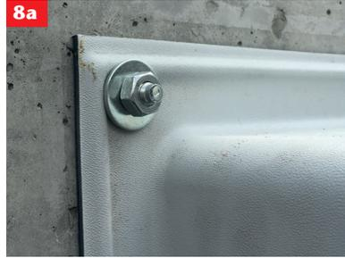
8. ACO Therm® Block anhängen und Muttern aufschrauben. ACO Therm® Block – Platte innerhalb von 8 Minuten an die Wand drücken und ausrichten.
