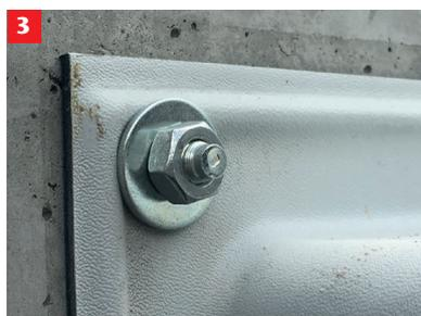
3. Bohrungen (10 mm) für die Montagehilfe in die Betonwand herstellen und Schwerlastanker einschlagen. ACO Therm® Block von der Wand nehmen.
