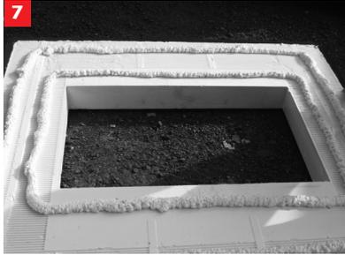
7. Dämmplattenkleber umlaufend in mehreren nebeneinander liegenden Raupen auf die Rückseite des ACO Therm® Blocks auftragen. Bitte ca. 5 cm Abstand zu der Außen- und Innenkante einhalten. Mengenbedarf je Block:
