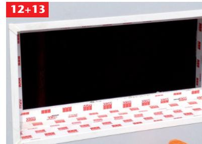
12. Beim Einsatz des ACO Therm® Blocks mit Fensterausparung nun das ACO Therm® Dämmanschlussprofil einsetzen. Hierzu die Schraubzwingen und die Dichtungsschnur der einbetonierten Thermzarge entfernen und das zusammengesteckte Dämmanschlussprofil in die außenseitige Zargennut einklicken.
