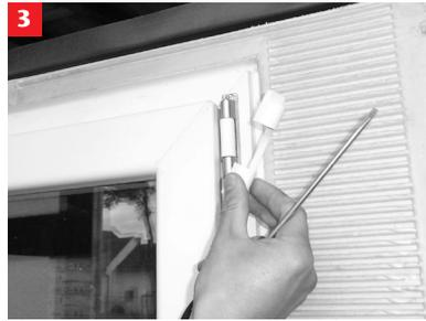
3. Fenstergriffe in Drehstellung lassen und Beschlagsabdeckung entfernen.
