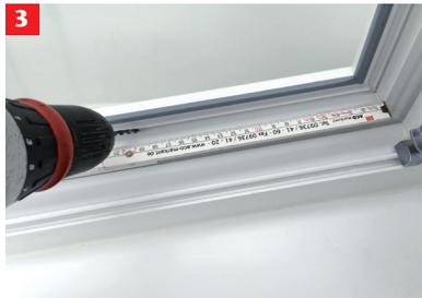
3. Von innen müssen ebenfalls zwei Bohrungen mit einem 4 mm Bohrer vorgenommen werden. Die inneren und äußeren Bohrungen sollten versetzt zueinander stehen, um Windgeräusche zu vermeiden. Im Idealfall sitzen die Bohrungen von der Innenseite der Zarge in einem Abstand von 20 cm entfernt. Durchbohren Sie im 45 Grad-Winkel die innere Wandung. Bitte achten Sie darauf, dass nicht tiefer als 1 cm gebohrt wird.
