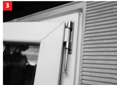
3. Axerarm dem Axerlager zuführen und den Axerstift bis zum Anschlag nach oben drücken.
