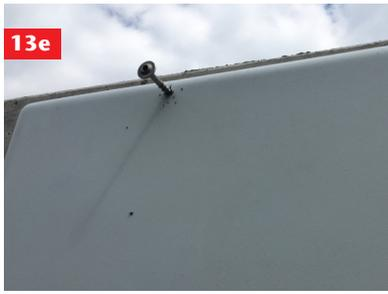
13. In der Zwischenzeit kann die druckwasserdichte Lichtschachtmontage erfolgen.
