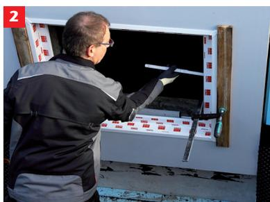
2. ACO Therm® Block vor die Thermzarge/Festeröffnung halten und ausrichten. Es ist darauf zu achten, dass die ACO Therm® Block Fensteraussparung bzw. die Fensterzarge im gleichmäßigen Abstand zur Thermzarge bzw. Betonleibung ausgerichtet wird. Den ACO Therm® Block durch die Fensteröffnung mittels Schraubzwingen fixieren.
