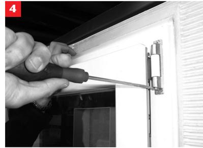
4. Fenster gut festhalten und Axerstift nach unten ziehen. Bei Bedarf Schraubendreher zu Hilfe nehmen.
