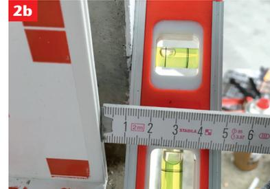
2. Schiebe Sie nun das Leibungselement soweit in die Nut der Fensterzarge, so dass das Leibungselement 10 mm tief in der Leibung sitzt. Entfernen Sie hierzu die weiße Dichtung an der Innenkante des Leibungselementes. Ein späterer Putzauftrag muss bereits berücksichtigt werden.
