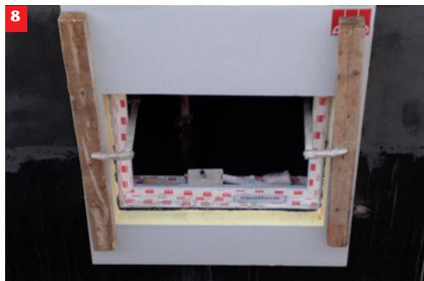
9. Bei der Verwendung eines Therm Blocks mit Fensteraussparung kann nun entsprechend der beiliegenden Montageanleitung das Dämmungsanschlussprofil montiert werden.
