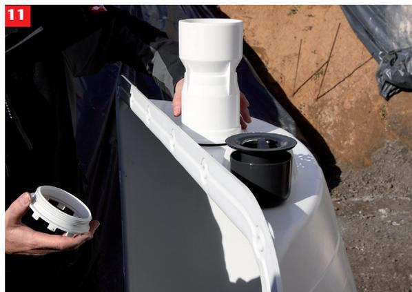
11. Nun kann mit der Lichtschachtmontage begonnen werden. Bitte den Entwässerungsanschluss bzw. die Verschlussplatte in die Entwässerungsöffnung des Lichtschachtes einschrauben.
