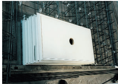
Nach Abschluss der Bewehrungsarbeiten wird unmittelbar vor dem Betoniervorgang das durch die äußere Montageplatte geschützte Leibungsfenster aufgesteckt. Ein zusätzliches Niederhalten ist in der Regel nicht erforderlich.
