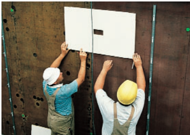
Montageplatte auf richtiger Höhe waagrecht fixieren.
