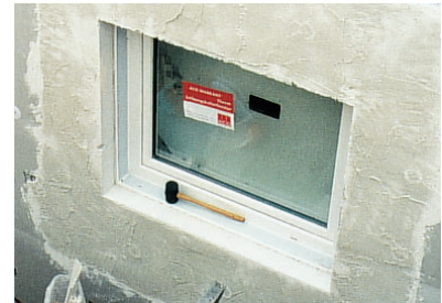
Das Dämmungsanschlussprofil ist leicht auf die vor Ort benötigten Dämmungsstärken von 100/80/60 cm oder 110-200 mm ohne Werkzeug anpassbar.
