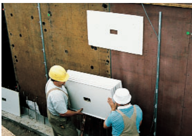
ACO Leibungsfenster Therm® auf die befestigte Montageplatte stecken und mit an den Leibungsfenstern angebrachten Lochstreifen sichern.
