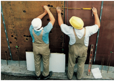
Position des Leibungsfensters/Montageplatte einmessen.
