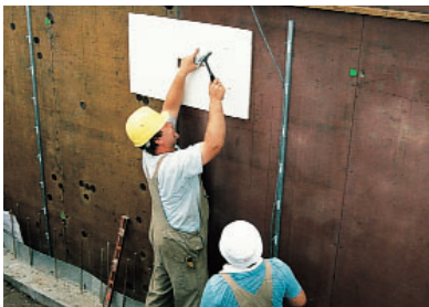
Montageplatte auf der Schalung befestigen.
