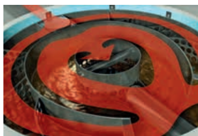
Simultane Trennung von Schlamm und Leichtflüssigkeit im gesamten Abscheideraum
