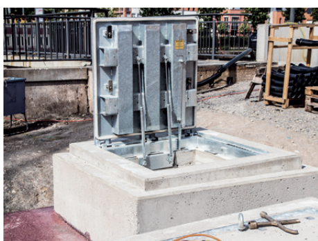
Sonderschachtabdeckungen mit Schutz vor Rückstau oder Überflutung
