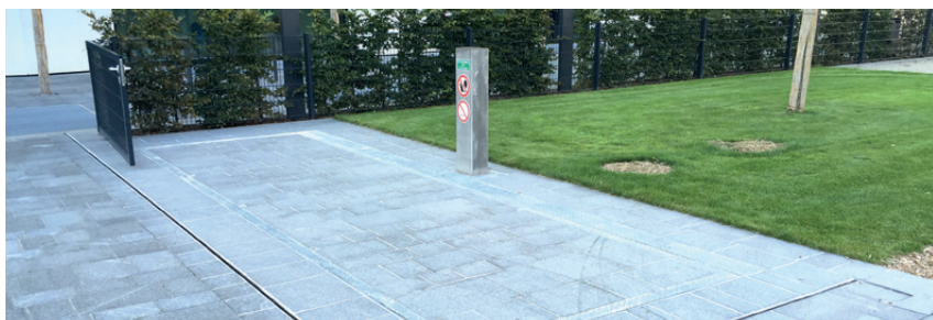
Sonderschachtabdeckungen bieten die Möglichkeit einer optischen Einpassung in das Gesamtbild
