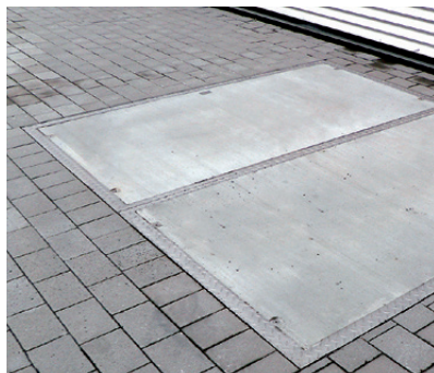
Kleine und handliche bzw. selten zu öffnende Schachtabdeckungen ohne Öffnungshilfe
