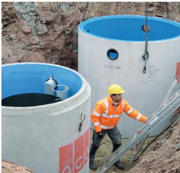
Alle Schachtprodukte folgen dem flexiblen Baukastenprinzip. Die einfache Artikelstruktur ermöglicht, Anlagen individuell zu konfigurieren. Anwender können Unterteile und Oberteile zeitsparend und schnell auswählen. In den Unterteilen sind bereits die Kabeldurchführung und eine Gleitringdichtung mit integriertem Lastabtrag enthalten. Dadurch entfällt das zeitaufwendige auftragen eines Mörtelbetts zum Lastabtrag.
