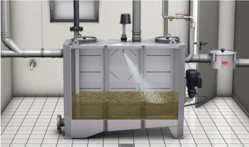
Hochdruckinnenreinigung bei einem Fettabscheider zur rückstandsfreien Entsorgung
