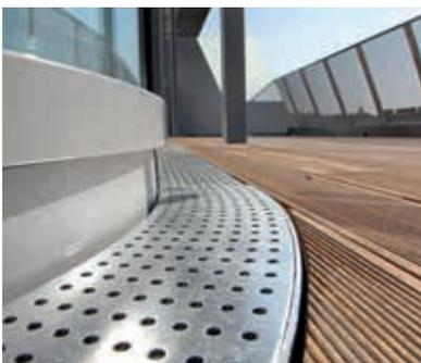
Im Wohn- und Bürogebäude Neutorgasse befinden sich in den oberen Geschoßen Luxuswohnungen mit direktem Ausgang auf die Dachterrasse. Das anfallende Fassadenwasser wird mittels ACO Profiline aufgenommen und abgeleitet. Im Bereich der gebogenen Glaselemente wurden an den Radius angepasste Rinnen und Roste verwendet.
