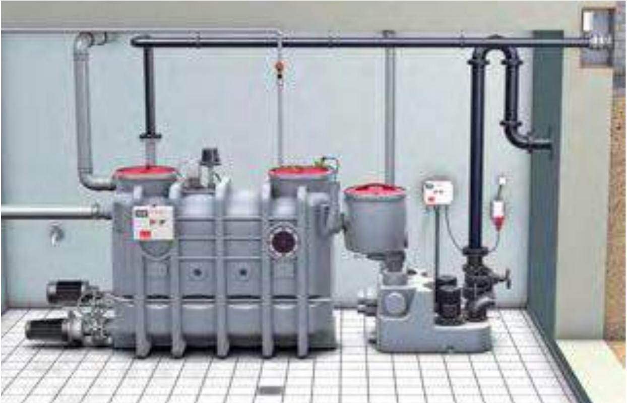
Alle ACO Fettabscheider werden gemäß den maßgeblichen Normen ÖNORM EN 1825 und DIN 4040-100 gefertigt. Die im Programm aufgeführten Fettabscheider sind hydraulisch getestet. Weiterhin unterliegen die Abscheideranlagen einer regelmäßigen Kontrolle, welche die Fettabscheiderfertigung auf die Einhaltung der aktuell gültigen Prüfnormen kontrolliert.
