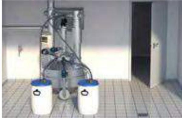
Um die abgeschiedenen Stoffe aus dem Fettabscheider in die Sammelbehälter leiten zu können, sind – je nach Betrieb – die entsprechenden Ablasshähne am Abscheider zu öffnen. Dies kann unabhängig vom Arbeitsprozess erfolgen. Beispielsweise muss der Betrieb in einer Küche hierzu nicht unterbrochen werden. Da sich in den Auffangbehältern nur das Fett und der Schlamm sammeln, muss der Fettabscheider nach der Entsorgung nicht mit kostbarem Frischwasser wiederbefüllt werden.
