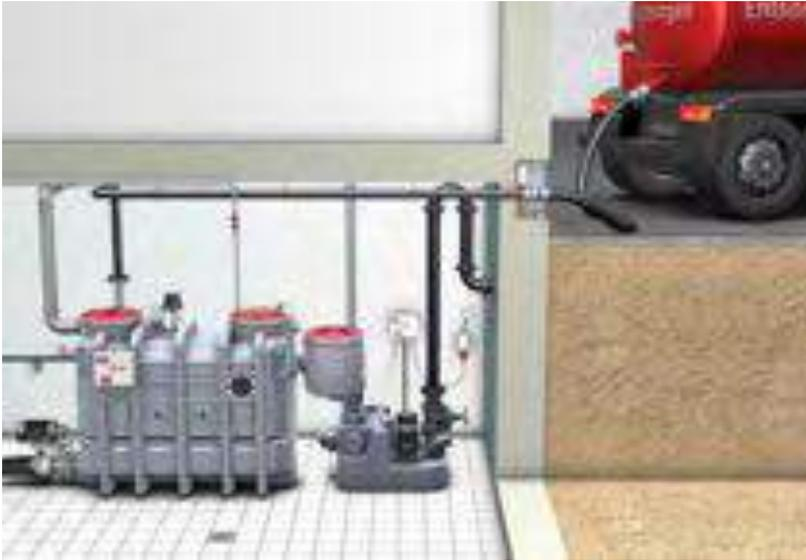
Ein Fettabscheider zur Vollentsorgung arbeitet rein physikalisch nach dem Schwerkraftprinzip (Dichteunterschied), d.h., schwere Abwasserinhaltsstoffe sinken auf den Boden, leichte Stoffe, wie z.B. tierische Öle und Fette, steigen im Fettabscheider nach oben. Über den Ablaufstutzen wird das gereinigte Abwasser der Kanalisation zugeführt.
