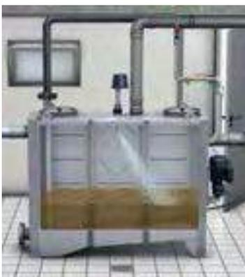
Hochdruckinnenreinigung bei einem Fettabscheider zur rückstandsfreien Entsorgung
