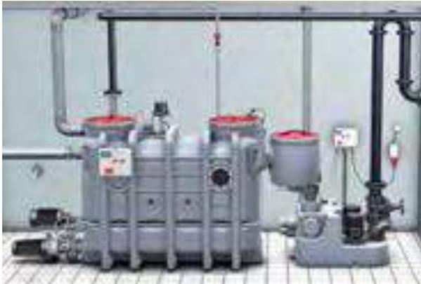
Abwasserhebeanlagen dienen der Förderung von Abwasser über die Rückstauenebene in die höher liegende Kanalisation. Der Einsatz von Abwasserhebeanlagen ist gemäß ÖNORM EN 12056 und ÖNORM B 2501 für Ablaufstellen unterhalb der Rückstauenebene vorgeschrieben, demnach bei fast allen frei aufgestellten Fettabscheideranlagen. Je nach Einsatzbereich bietet ACO eine Auswahl an verschiedenen Abwasserhebeanlagen die direkt hinter den Fettabscheidern montiert werden können.
