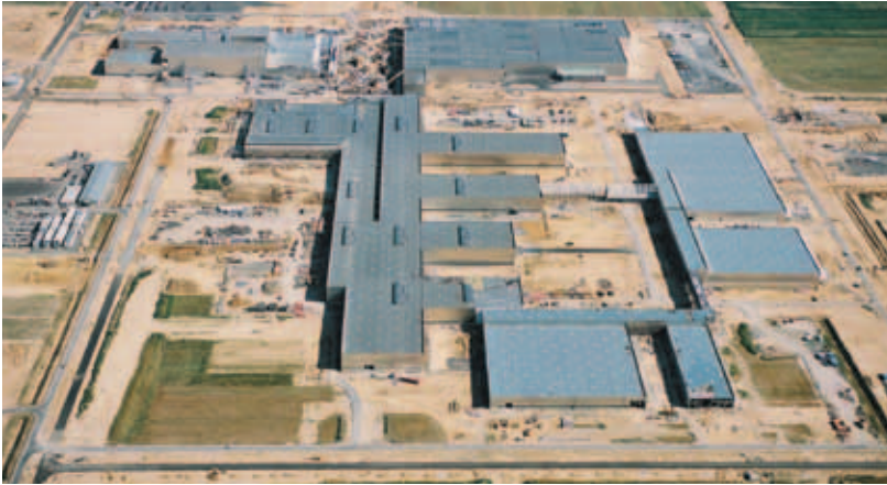
BMW, Leipzig 85000 m 2 Dachfläche
