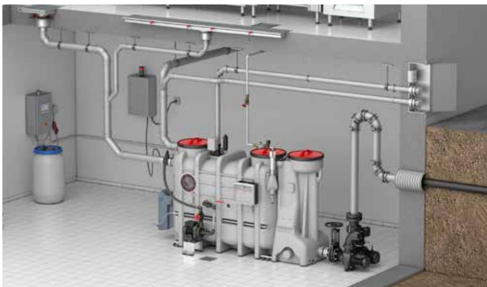
Die Entsorgungsleitung von Fettabscheidern kann mit ACO Pipe 1.4404 hergestellt werden. Im Lieferprogramm von ACO Haustechnik befinden sich Übergänge, die eine einfache Verbindung mit ACO Pipe Rohr ermöglichen. Je nach Anwendungsfall (Fettabscheider mit oder ohne Entsorgungspumpe) sind die Verbindungselemente mit zusätzlichen Sicherungselementen zu versehen.
