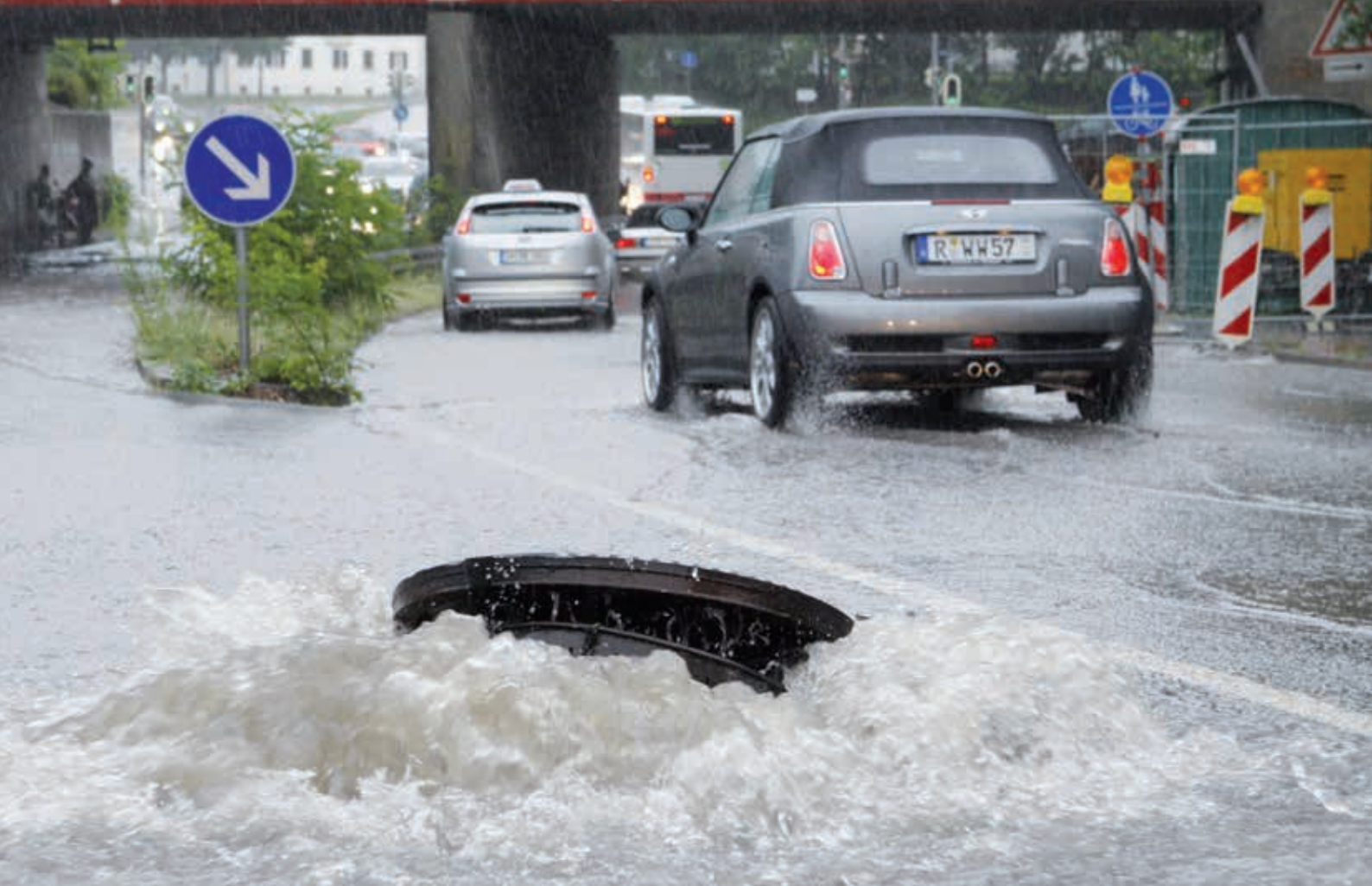
Überlastung der Kanalisation durch Starkregen
