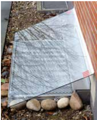
Die ACO Lichtschachtabdeckung aus Einscheibensicherheitsglas (ESG) inklusive Befestigungszubehör und Dichtungsband
