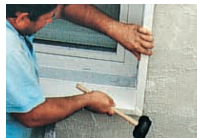
4. Durch Einschlagen in die Nut befestigen (z. B. Gummihammer). Abdichtung zwischen Dämmungsanschlussprofil und Fassade kann mit handelsüblichen Dichtstoffen erfolgen.
