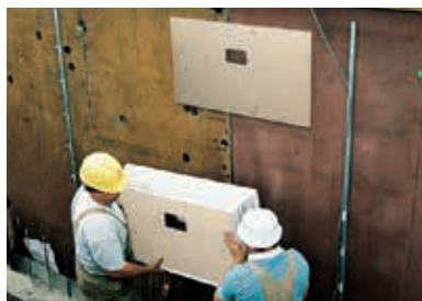
4. ACO Therm® Leibungsfenster auf die befestigte Stützplatte stülpen und mit den seitlich angebrachten Lochbändern sichern.
