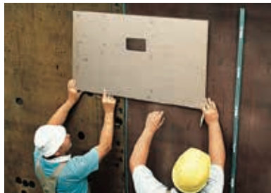
2. Stützplatte waagrecht fixieren.
