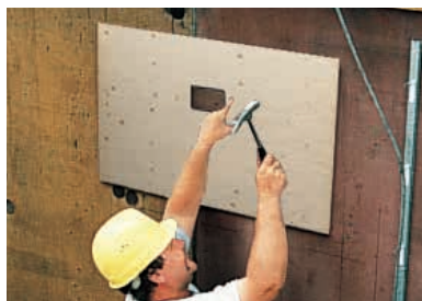
3. Stützplatte auf der Schalung befestigen.
