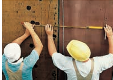
1. Leibungsfenster/Stützplatte einmessen.
