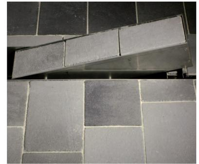
ACO DRAIN® Revisionschlitzrahmen mit Pflastersteinen belegt
