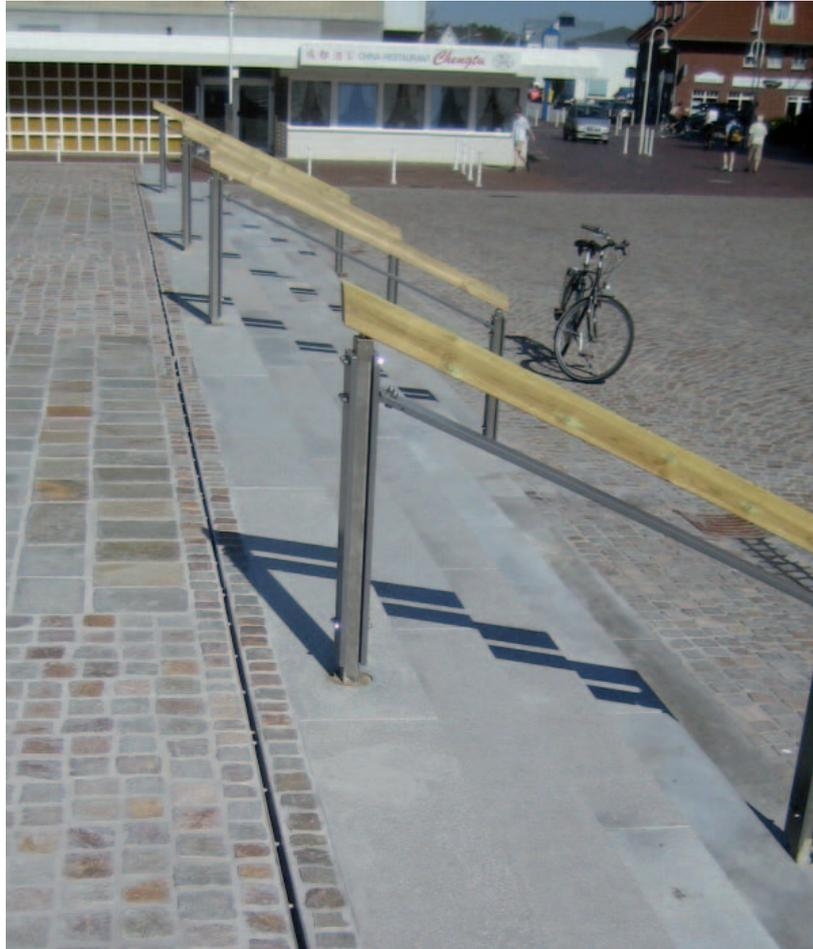
Oberflächenentwässerung dezent und elegant: Der Schlitzrahmen fügt sich unaufdringlich in die Freifläche mit Stufenanlage ein. Bauvorhaben: Westerland/Sylt.
