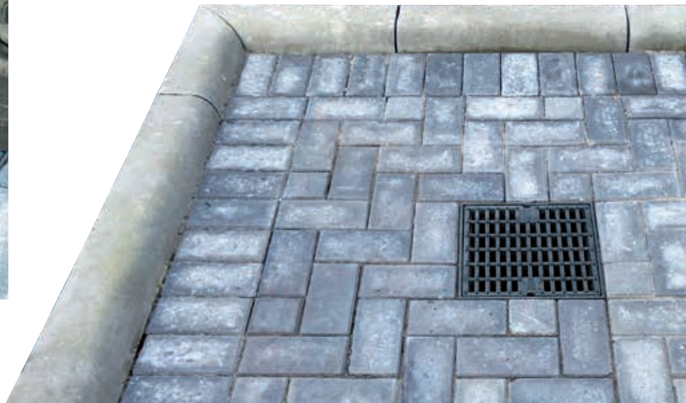
In dieser Ausführung befahrbar bis Klasse D 400
