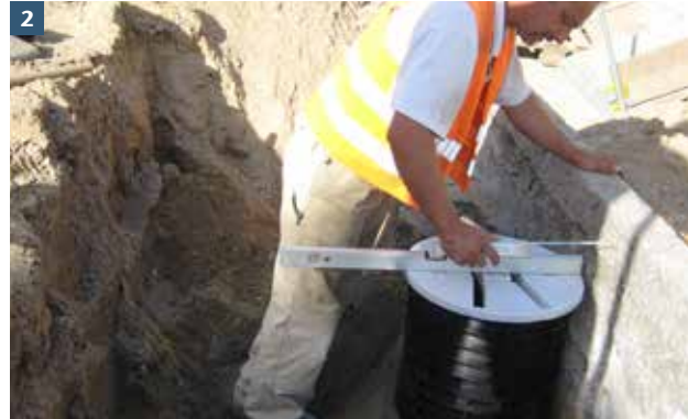
2 Optimale Ausrichtung des Ablaufs inkl. Aufsatz durch die Drehbarkeit, Teleskopierbarkeit und Anpassung an die jeweilige Quer- bzw. Längsneigung.
