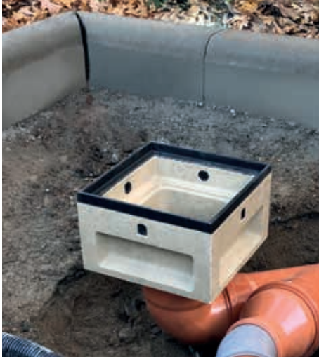
Multipoint D 400 mit eingegossener Gusszarge in der Ausführung Kurzform
