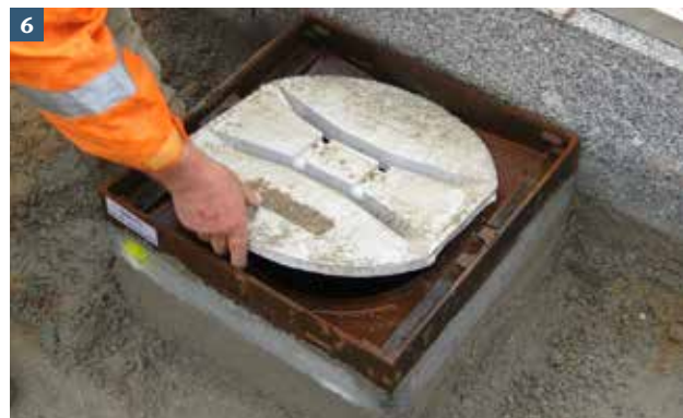
6 Aufsatz mit Betonaufleger. Die Kunststoffrippen müssen vollständig mit Beton verfüllt sein. Die EPS-Schalungshilfe kann nach Abknicken an den Sollbruchstellen als Verschlussdeckel gegen Schmutzeintrag in der Bauphase eingelegt werden.
