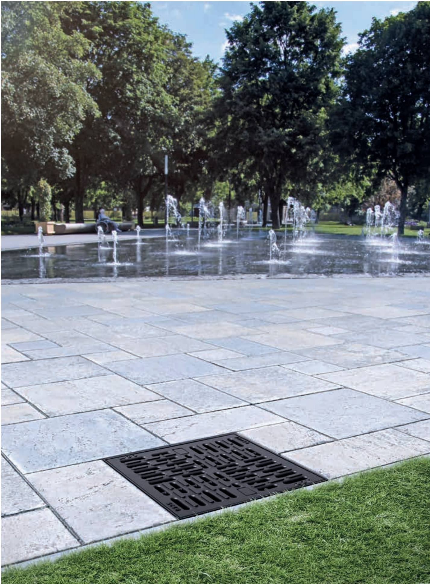
Auch in Parkanlagen sind Punktabläufe eine gute Sammelstelle für Schmutz- und Regenwasser
