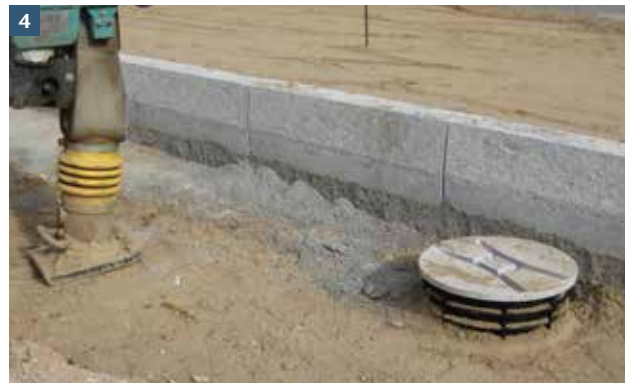
4 Verfüllen nach ÖNORM EN 1610 mit entsprechendem Verfüllmaterial nach DIN 18196. Verdichten mit leichtem Verdichtungsgerät bis zur Markierung „Unterkante Beton“ auf dem obersten Kunststoffelement.
