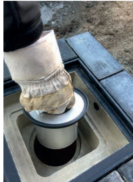
Nachträglich einsetzbarer Geruchsverschluss
