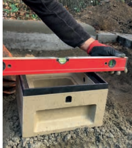
Ausrichten des Ablaufkörpers in der Betonbettung
