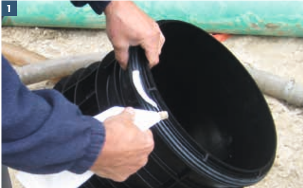
1 Vorbereitung der Oberteile durch Auftragen des Gleitmittels vor dem ineinanderstellen.
