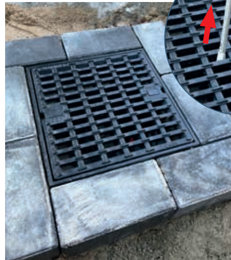
Einlegen des Abdeckrosts. Der Rost ist gesichert nach dem Einrasten der Arretierung
