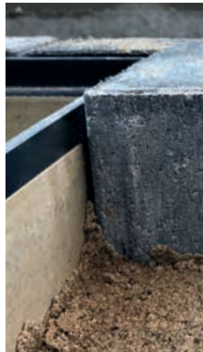
3–5 mm überhöht eingebautes Pflaster um den Ablaufkörper
