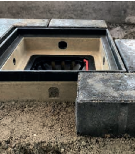
Direktes Anarbeiten des Pflasterbelags
