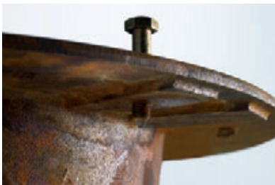
Aufgrund der durch den Flansch gehenden Schraube ist eine sichere, dauerhafte Abdichtung nicht möglich
