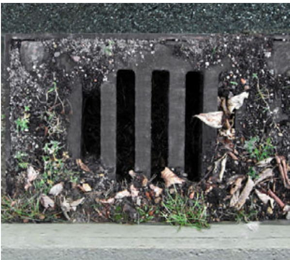
Trotz großer Einlaufquerschnitte sind häufig die freien Querschnitte zwischen Roststabunterseite und Gehäuse zu klein und verstopfen weite Bereiche des Ablaufes kurzfristig
