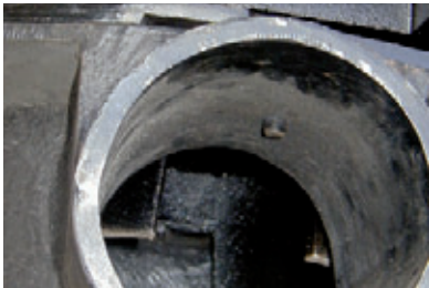
Ablauf mit Schraube in der Rohrleitung ermöglicht keine vollständige Abdichtung
