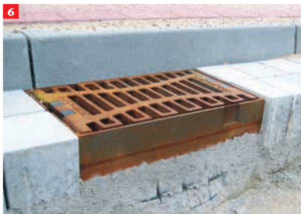
6 Aufsatz mit Betonaufleger, zur Fahrbahnmitte hin abgeschrägt. Die Kunststoffrippen müssen vollständig mit Beton verfüllt sein.
