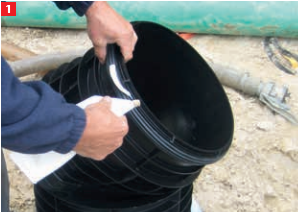
1 Vorbereitung der Oberteile durch Auftragen des Gleitmittels vor dem Ineinandersetzen.
