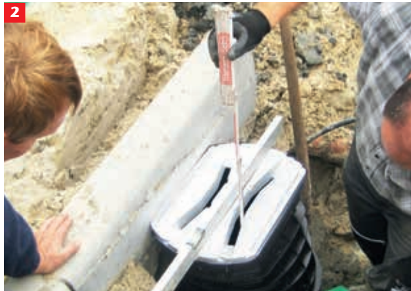
2 Optimale Ausrichtung des Ablaufes inkl. Aufsatz durch die Drehbarkeit, Teleskopierbarkeit und Anpassung an die jeweilige Quer- bzw. Längsneigung.
