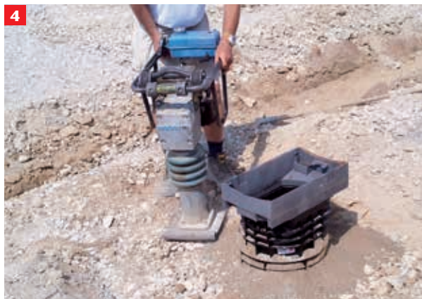
4 Verfüllen nach ÖNORM EN 1610 mit entsprechendem Verfüllmaterial. Verdichten mit leichtem Verdichtungsgerät bis zur Markierung „Unterkannte Beton“ auf dem obersten Kunststoffelement.
