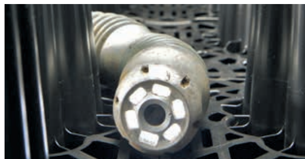
Schiebekamera, Reinigungsgerät mit Spülkopf
