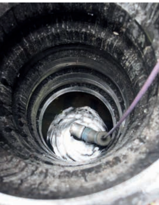
Vertikaler Zugang direkt über der Rigole
