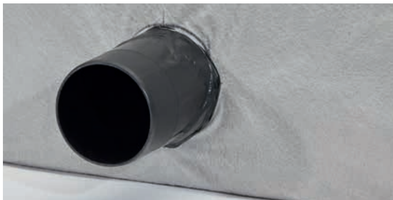
Das Geotextil wird eingeschnitten und über den Rohradapter geschoben
