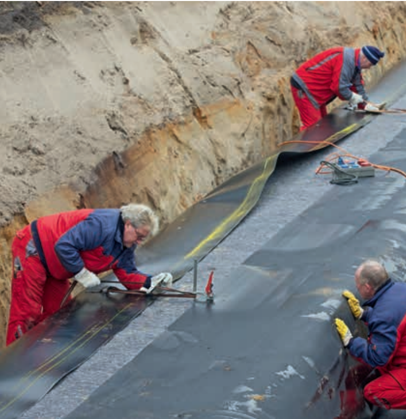
Das Blockspeichersystem wird mit einem inneren Schutzvlies und einer Abdichtungsbahn umhüllt
