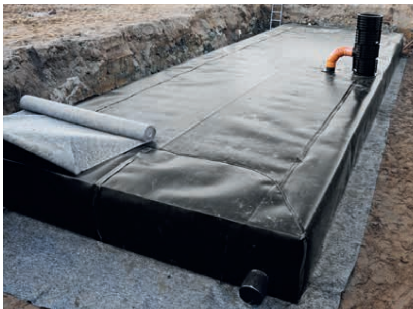
Nach dem Fertigstellen der Abdichtungsbahn wird das äußere Schutzvlies angelegt
