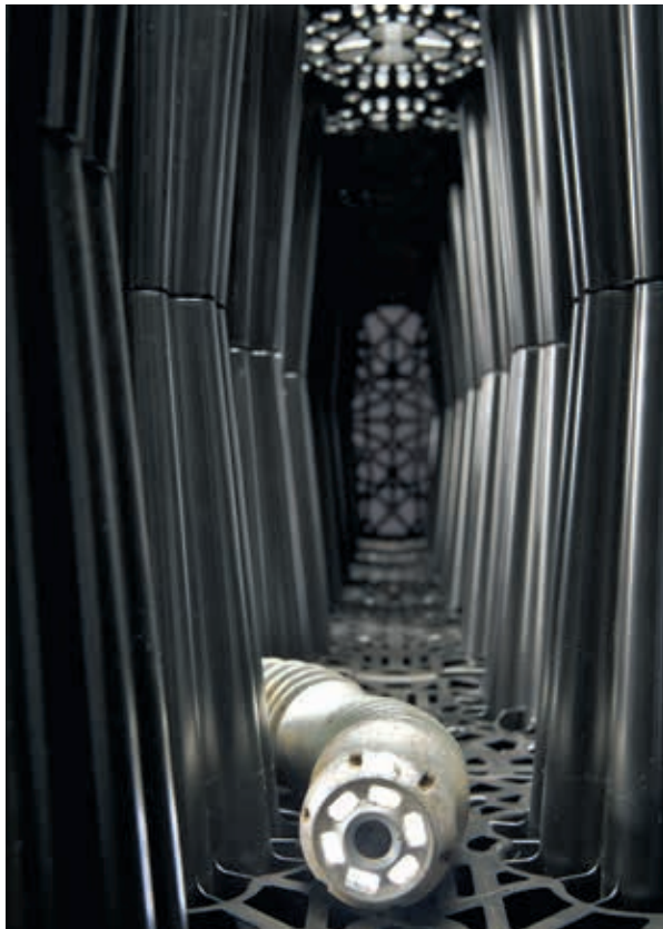
Schiebbare Inspektionskameras können einfach im Rigolensystem eingesetzt werden
