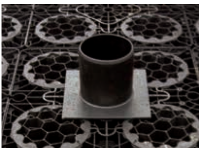
Der Rohradapter wird in die zuvor ausgeschnittene Öffnung nach oben montiert
