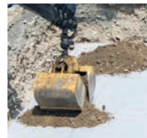
Verfüllen der Rigole
