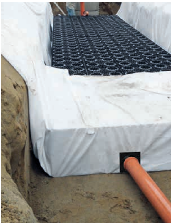
Abschließend wird das schützende Geotextil um die Rigole gelegt, sodass sie vollständig umhüllt ist
