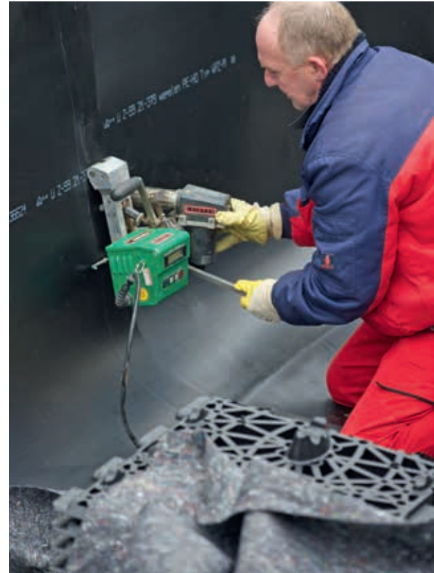
Abschließend wird die Abdichtungsbahn verschweißt
