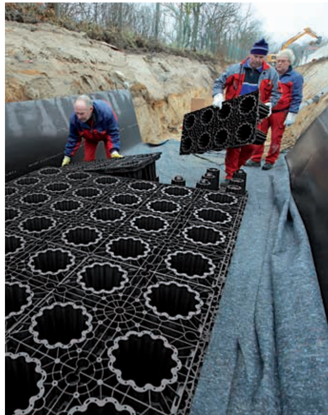
Kurze Wege zur Palette erhöhen das Verlegetempo
