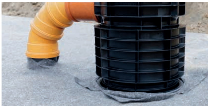
Das Geotextil wird eingeschnitten und über den Rohradapter geschoben
