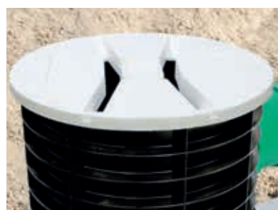
Die Schalungshilfe/Bauzeitabdeckung muss während der gesamten Bauphase die Öffnung schützen
