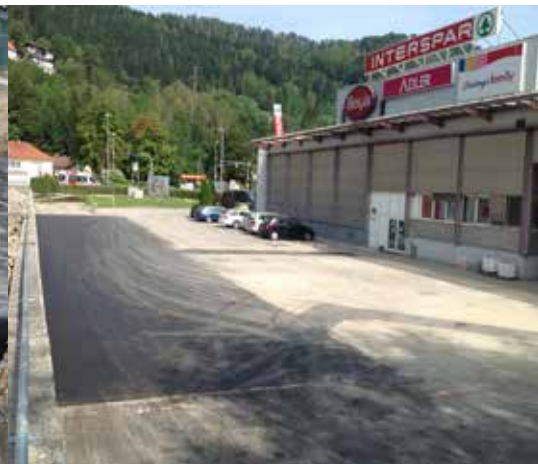
Fertiger Einbau der Versickerungsrigole der Dachflächen NORD/SÜD
