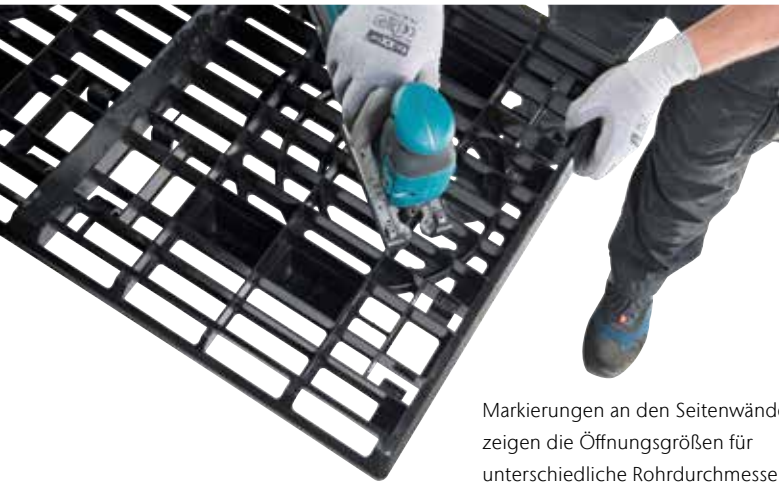
Kurze Rohrseite in Rigolenanlage montieren!
