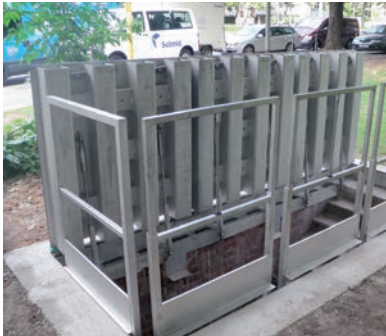
Dreiteilige Abdeckung mit Öffnungshilfe und Klappgeländer, Frankfurt
