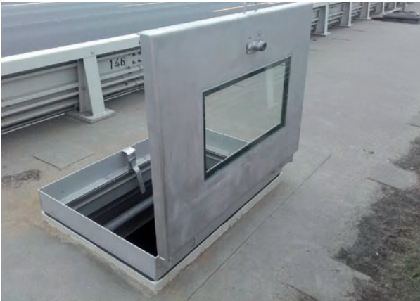
Kleiner Notausstieg mit Handöffnung
