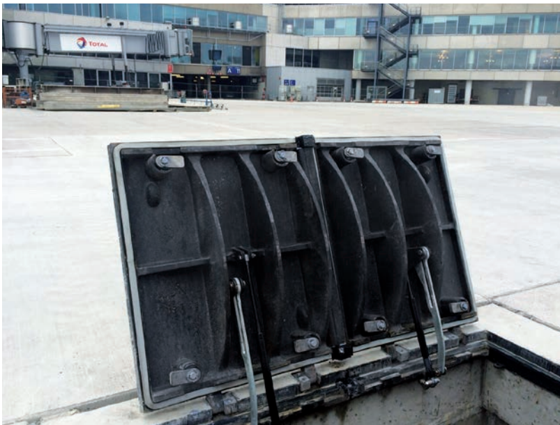
Kabelschachtabdeckung tagwasserdicht mit Stahlbetonrahmen, Belastungsklasse F900, Frankfurt
