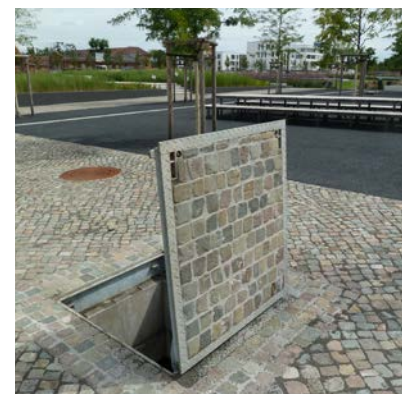
Abdeckung mit aufplasterbarer Oberfläche, Landau
