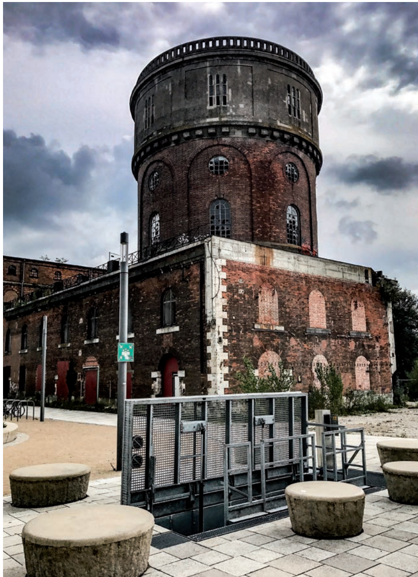
Notausstieg mit hydraulischem Antrieb als Gitterrost, Ingolstadt
