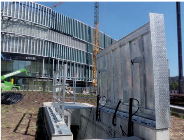
Hydraulischer Notausstieg, Frankfurt
