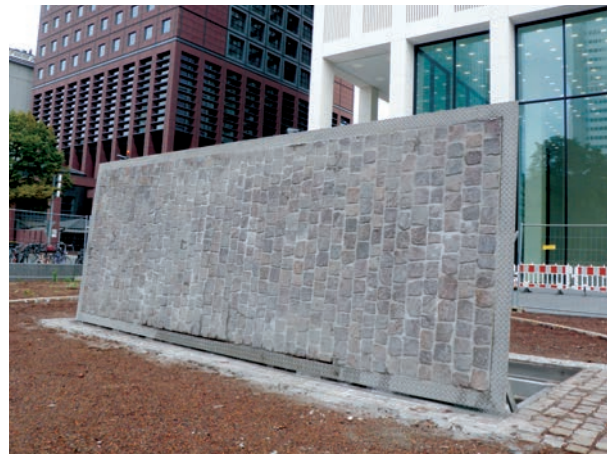
Notausstieg mit ausgepflastertem Deckel, Frankfurt
