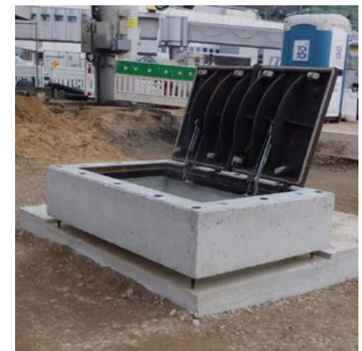
Kabelschachtabdeckung tagwasserdicht als Fertigteil mit höhenverstellbarem Stahlbetonrahmen, Düsseldorf
