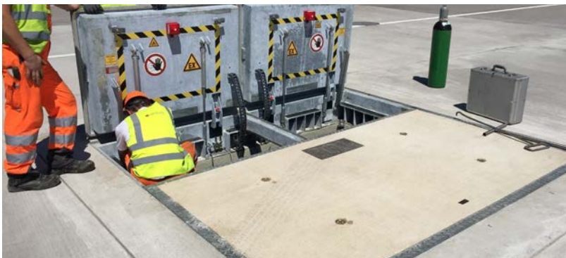
3-teilige Abdeckung mit zwei Revisionsöffnungen, F900
