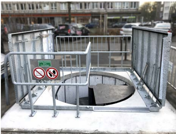
Notausstiegsabdeckung, begebar, manuell bedienbar, Essen
