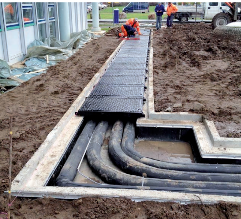
Reihenabdeckung aus Guss, Belastungsklasse B125, Heidelberg
