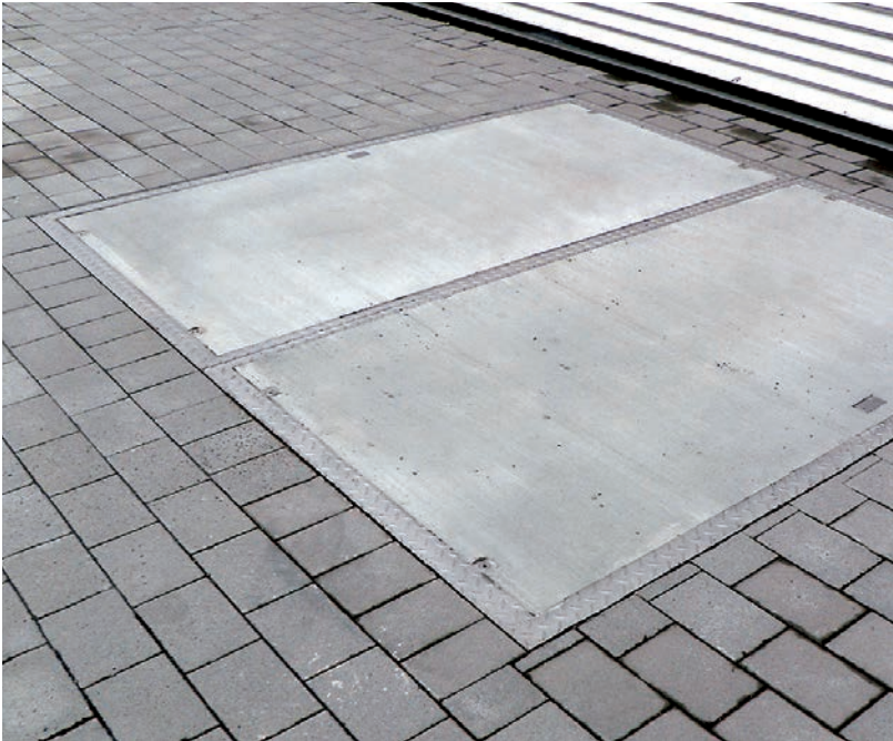
2-teilige Schachtabdeckung mit Betonoberfläche, Frankfurt
