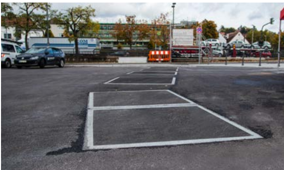
Rückstausichere Abdeckungen mit Asphaltfüllung, D400, Ansbach
