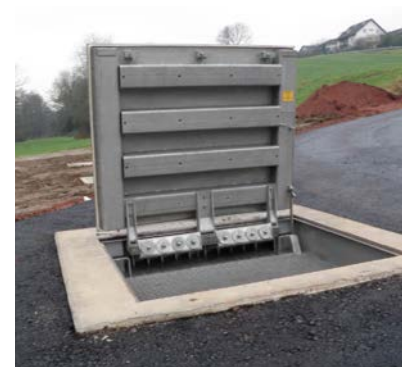
Abdeckung mit Federantrieb als Öffnungshilfe, Saarlouis
