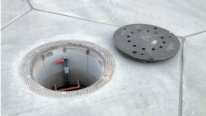
Gussabdeckung mit Schraubvorreiber-Verschlüssen Belastungsklasse F900, lichte Weite 800 mm
