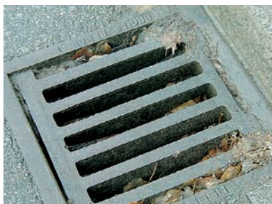
Üblicher Zustand der Aufsätze in Verkehrsflächen
