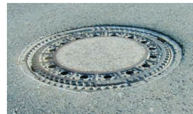
Üblicher, vertiefter Einbau
