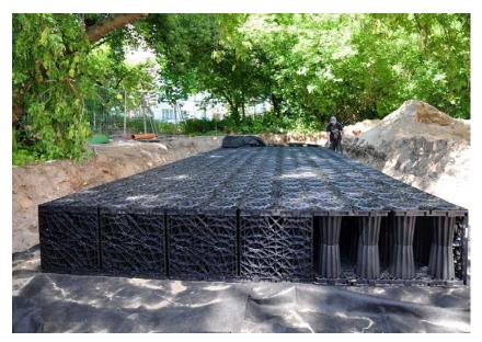
Basis von Stormbrixx sind Grundelemente, Seitenwände und Abdeckungen, die mittels eines intelligenten Stecksystems in der Baugrube zu einem Gesamtsystem zusammen gesetzt werden.
