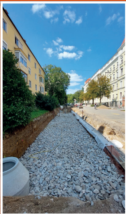
Nach dem ‚Stockholmer Modell‘ wird ein breiter Horizont Grobschlag in den neuen Straßenraum eingebracht und verdichtet. Fotos: Stadt Graz/ Pötsch
