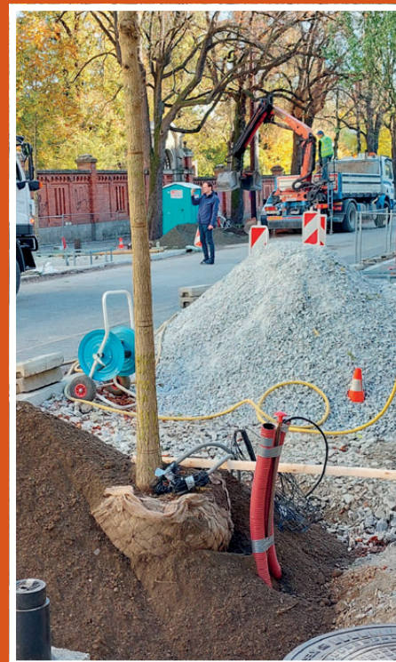
Messtechnik im Untergrund gibt Auskunft über Wechselwirkungen und Leistungen der Bäume im Schwammstadtsystem.
