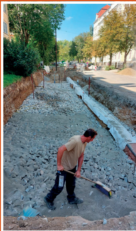
Zur Nährstoffversorgung der Bäume wird Kompost-Pflanzenkohle-Gemisch gleichmäßig verteilt und mit Wasserdruck in den Schotter eingewaschen.
